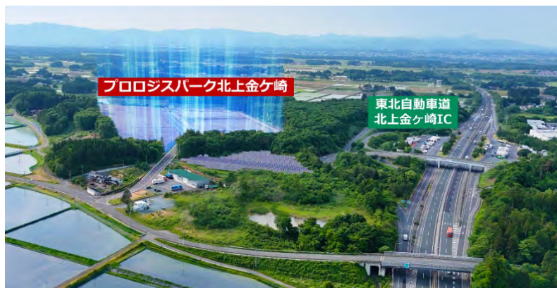
北上金ヶ崎 IC に隣接した開発地
